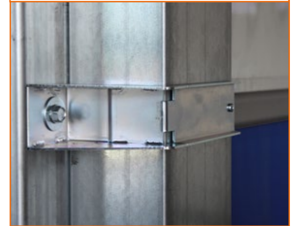
Verstärkungswinkel für höheren Windlastklasse
